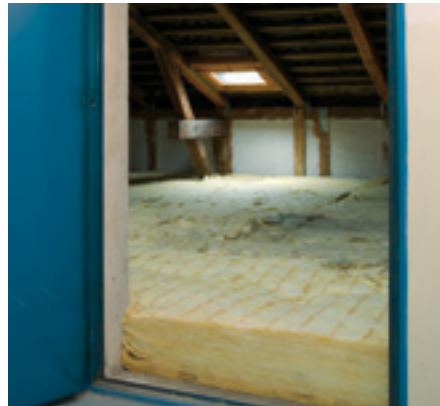
Dämmen der obersten Geschossdecke
